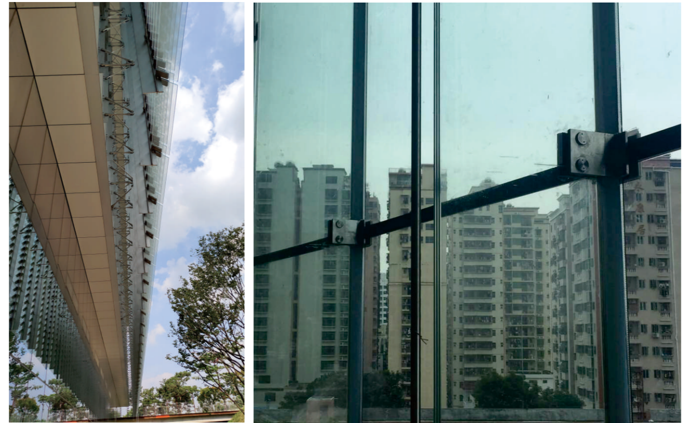
钢筋结构玻璃幕墙系统
